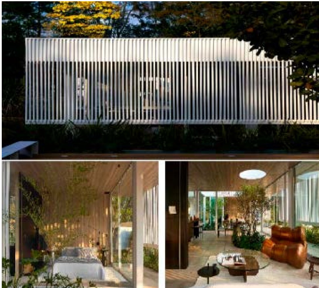
Figura 3 - Edificação modular, construída com steel frame.
