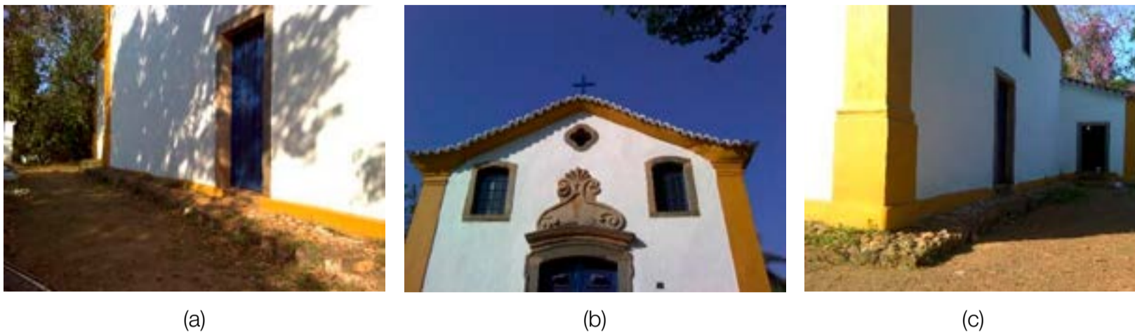
Figura 3 – Vista externa da capela de Sant’Ana do Arraial Velho.
