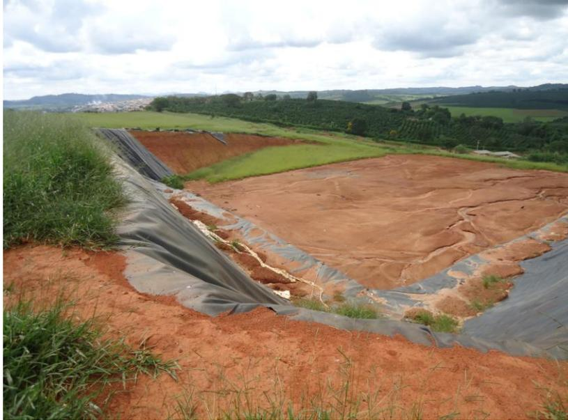
Figura 12 Aterro Controlado de Nepomuceno/MG (em construção)
