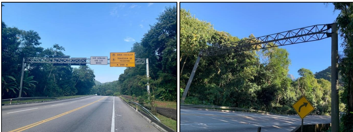
Figura 18 – Estruturas metálicas utilizadas pela fauna arborícola e semiarborícola para travessia da rodovia.
