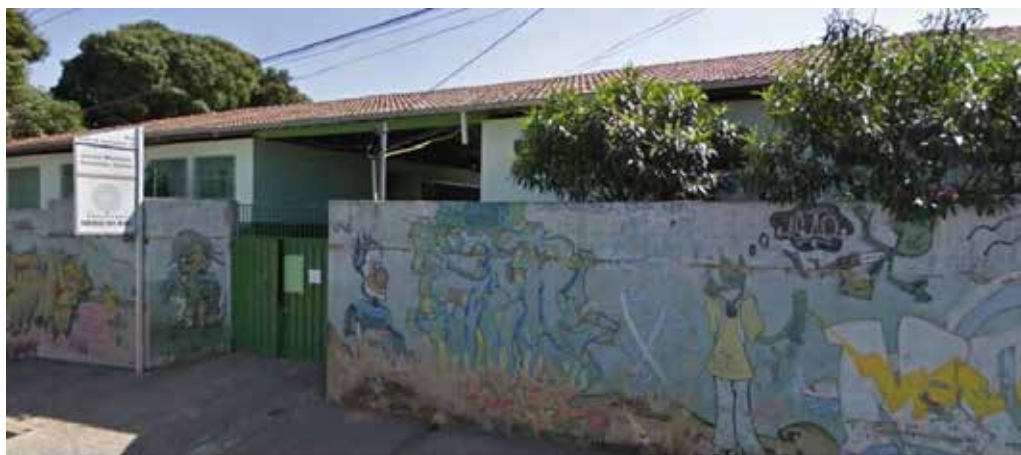
Figura 2 – Detalhe da entrada principal da E. M. Sebastião Gomes, Ribeirão das Neves, região metropolitana de Belo Horizonte / MG.
