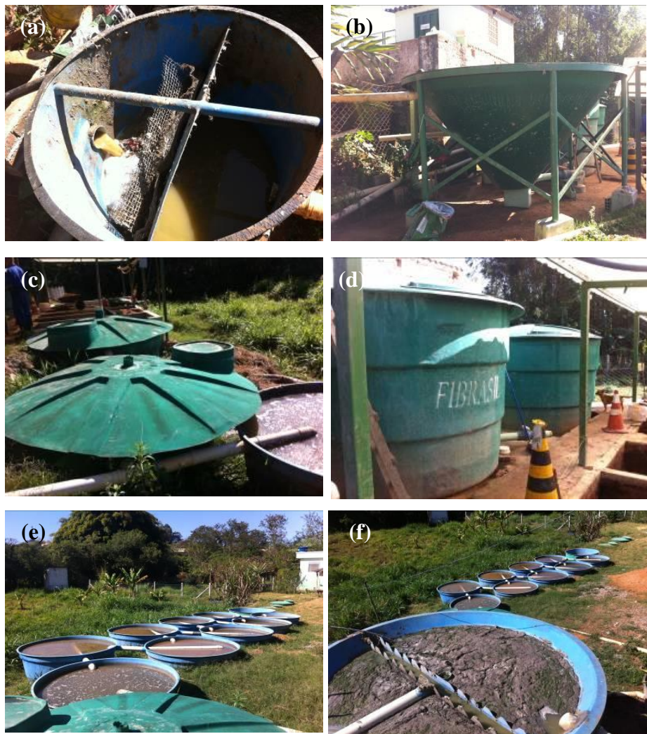
Figura 3 Sistema de tratamento da água residuária do canil Parque Francisco de Assis de Lavras-MG: efluente gerado com a lavagem das baias sendo tratado preliminarmente em uma grade (3a); tratamento primário (decantador) (3b); tratamento primário/secundário composto por tanque séptico e filtro anaeróbio com capacidade de 5.000 L cada (3c) e 10.000 L cada (3d); tratamento complementar - tanques de estabilização (3e); vista parcial do sistema de tratamento (3f).
