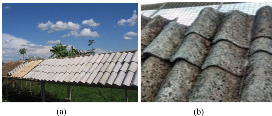
Figura 5 Telhas expostas na bancada em 2005 (a) e em 2015 (b)
