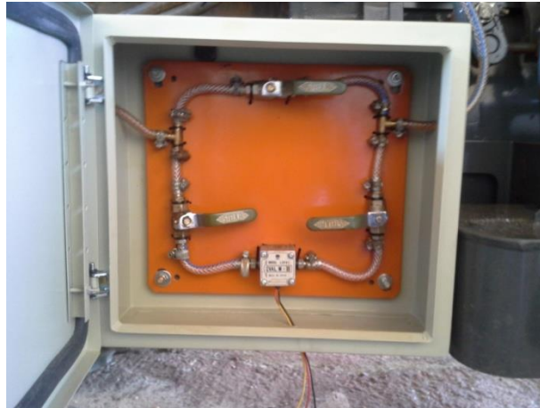
Figura 5 - Esquema de ligação do Fluxômetro.
