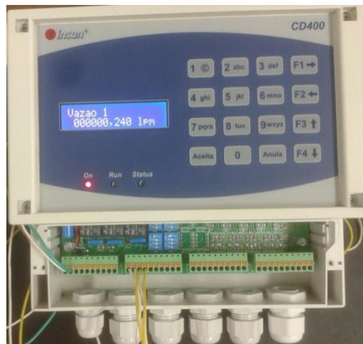
Figura 6 - Data Logger Incon CD 400.
