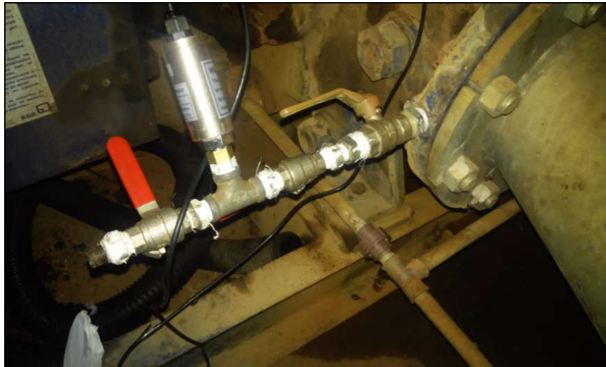
Figura 8 Esquema de instalação do transdutor de pressão absoluta na entrada da bomba.
