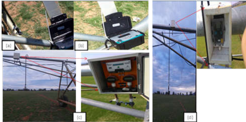
Figura 12 Transdutores de pressão da marca Lamon (a,b), Dwyer (c) e Dikson (d) instalados na lateral do pivô central.
