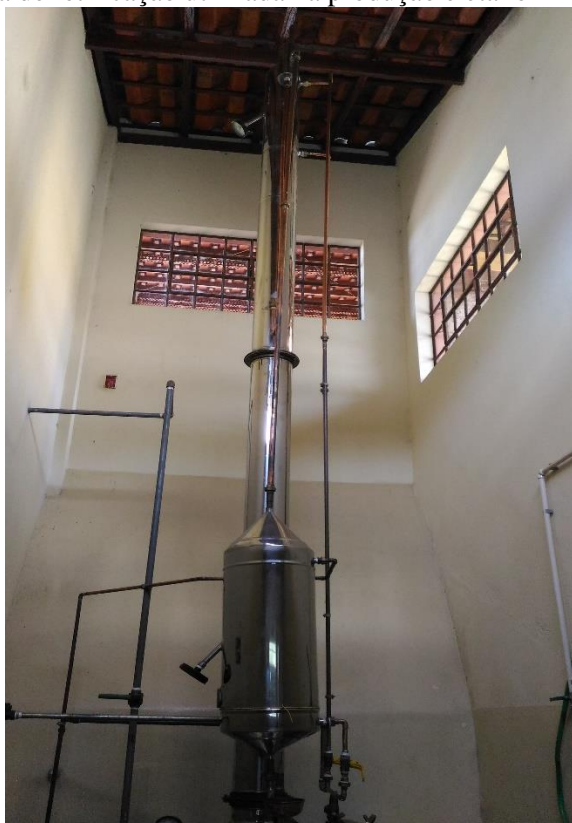
Figura 21 – Coluna de retificação utilizada na produção e etanol
