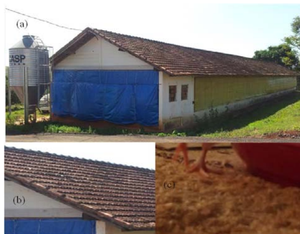
Figura 1 Galpão experimental em alvenaria com tijolos furado e com muretas laterais (a); telhas de barro (b); cama de palha de arroz (c)
