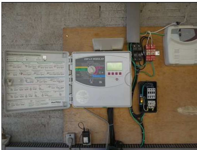
Figura 3 Controlador Lógico Programável utilizado para realizar as irrigações das parcelas dos tratamentos experimentais
