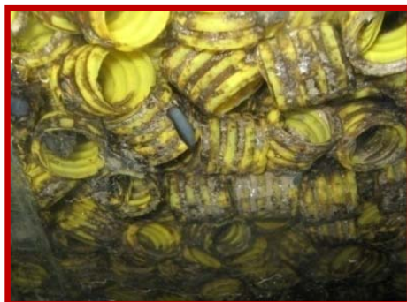
Figura 3 Crescimento fúngico ao redor do suporte conduíte
