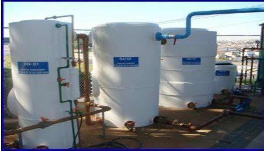
Figura 3 - Biodigestor modelo UASB/RALF.
