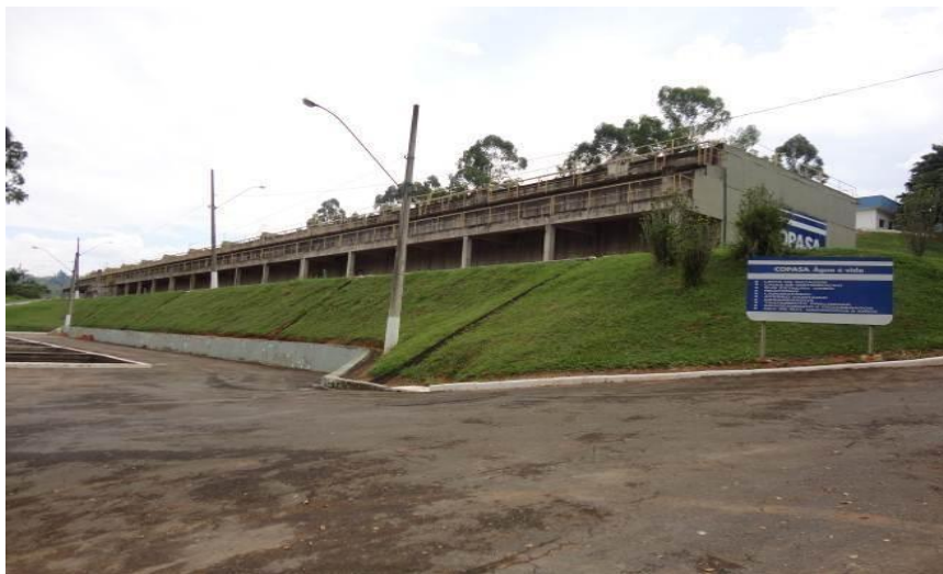
Figura 8 - Reatores UASB - ETE Santana/Varginha.
