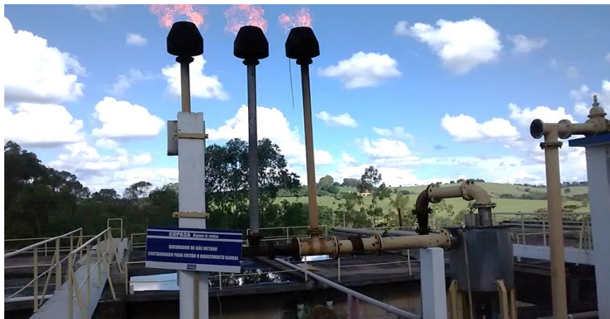
Figura 9 - Queimadores da ETE Santana
