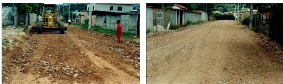
FIGURA 16 – Sub-base de ruas da cidade de Belo Horizonte executadas com material reciclado tipo B.
