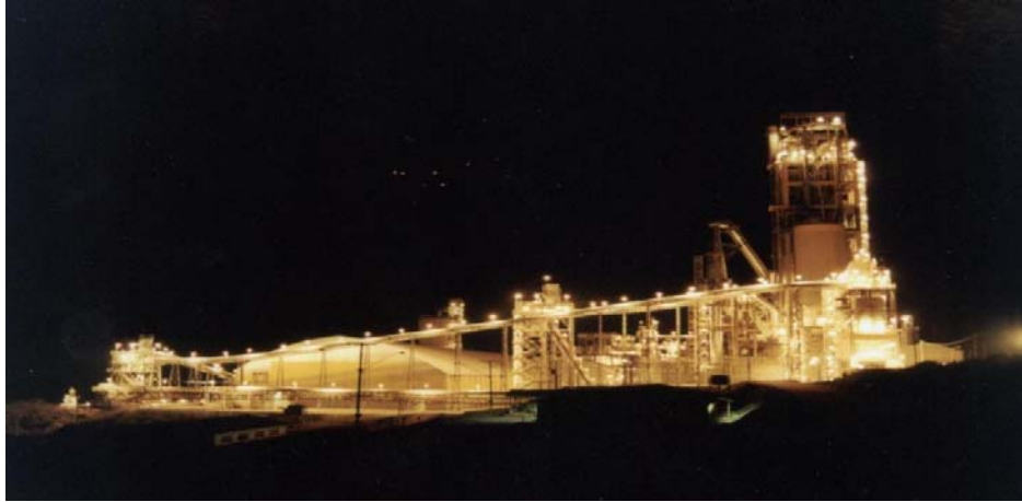
FIGURA 2 Fábrica de cimento CAUÊ em visão noturna.
