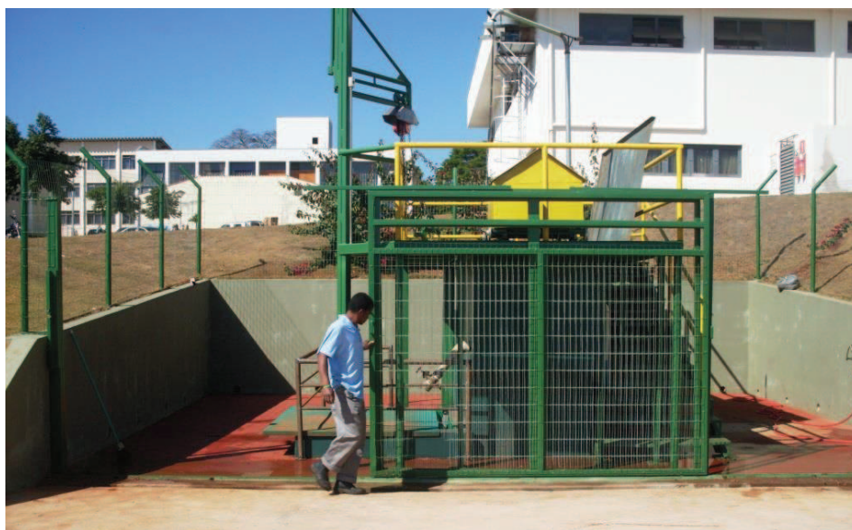
Figura 1 Vista frontal da caixa de gordura (CG)
