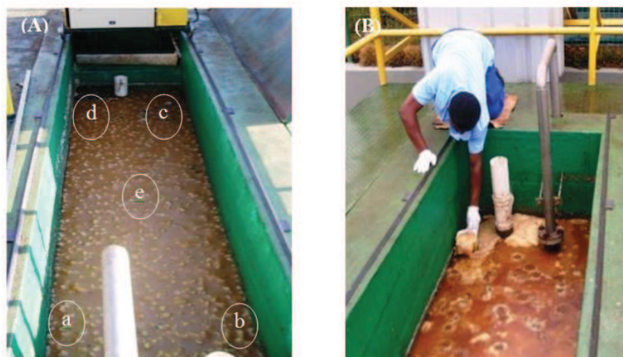
Figura 8 Pontos de coleta de gordura (A) e coleta de gordura na 1ª etapa (B)
