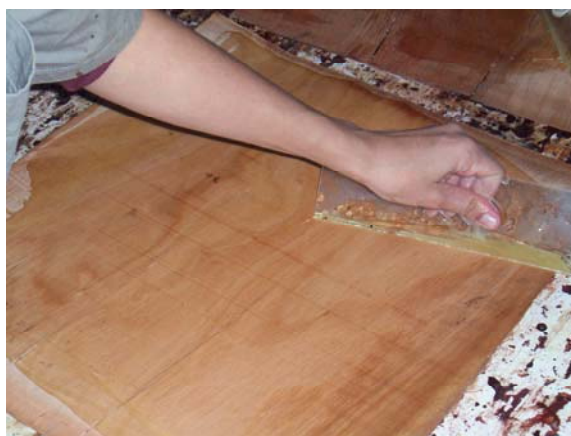
FIGURA 9. Aplicação do adesivo.
