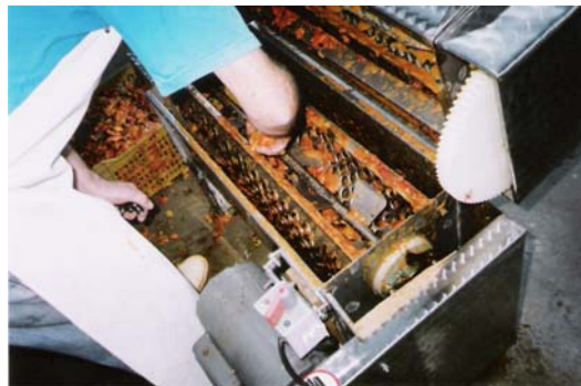
FIGURA 21 Parte interna do equipamento
