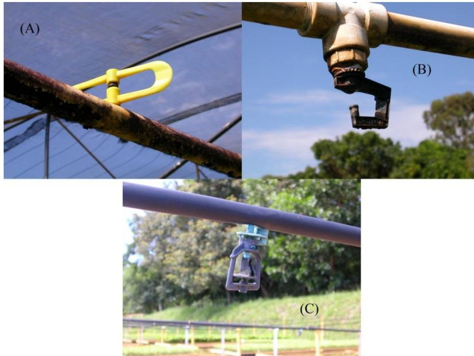
Figura 1 Microaspersores MECPREC MA-20 (A), Antelco *Inverted Rotor Spray* (B) e Plastro Rondo (C), instalados no viveiro de mudas florestais em Itutinga – MG
