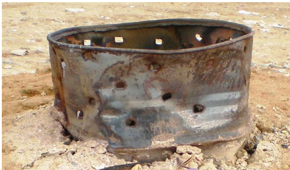
Figura 19 Sistema de coleta e queima de gases do Aterro Controlado de Divinópolis/MG
