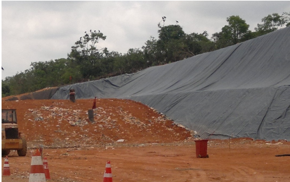
Figura 17 Recebimento e revestimento dos RSU no Aterro Controlado de Divinópolis/MG
