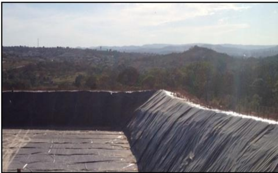
Figura 20 Instalação da membrana PEAD na célula do aterro controlado de Divinópolis/MG
