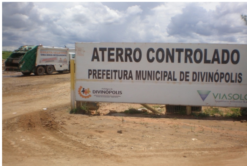
Figura 13 Vista parcial da entrada do aterro controlado do município de Divinópolis/MG
