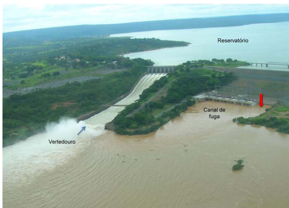
Figura 1 Imagem aérea da Usina Hidrelétrica de Três Marias. A seta indica a área onde o estudo foi realizado (Foto: Francisco de Andrade)
