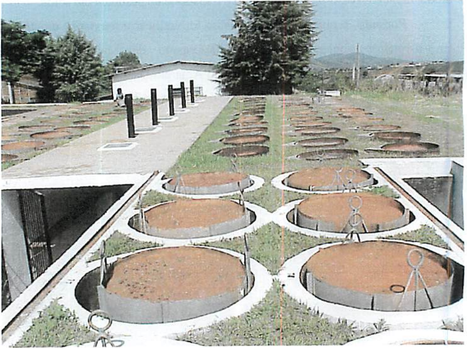
FIGURA 3.1. Vista parcial dos lisímetros do Departamento de Ciência do Solo da Universidade Federal de Lavras.
