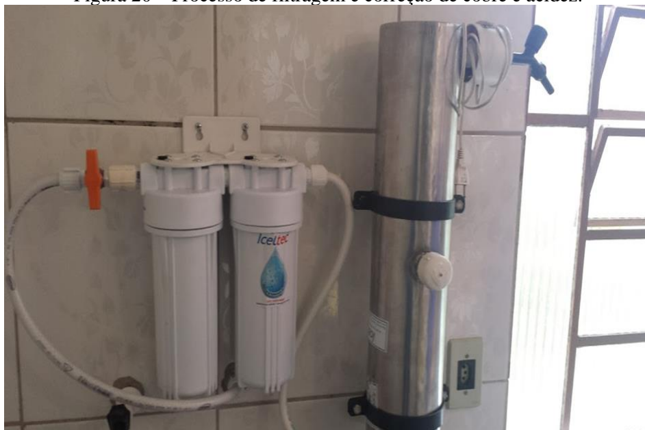
Figura 20 – Processo de filtragem e correção de cobre e acidez.
