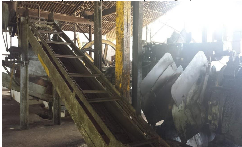
Figura 7 – Esteira que leva o bagaço da cana após a moagem para as fornalhas.
