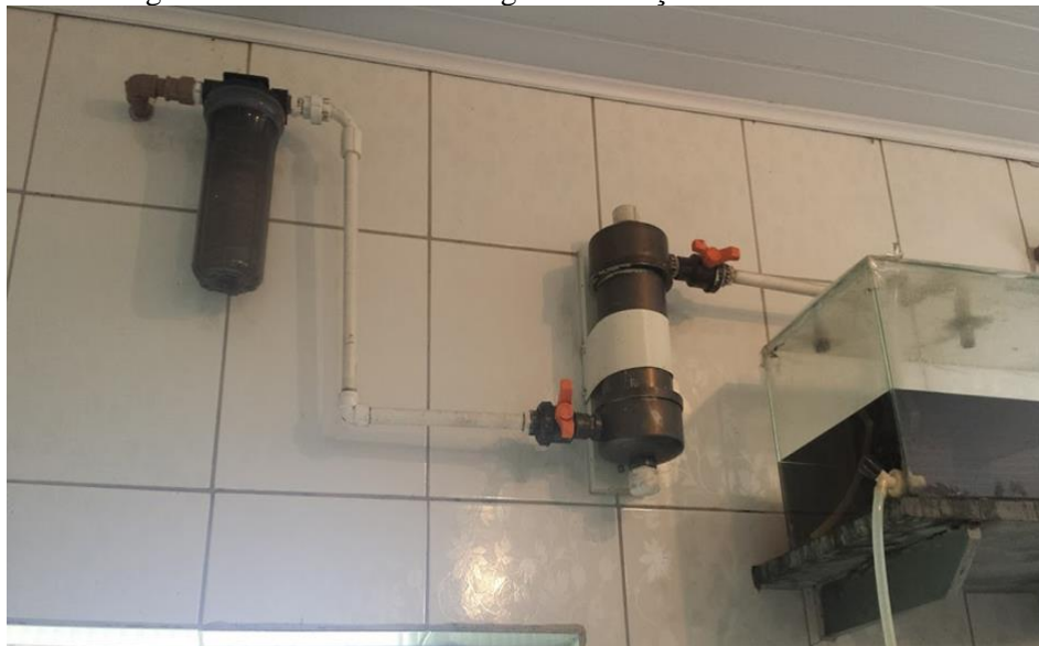
Figura 19 – Processo de filtragem e correção de cobre e acidez.
