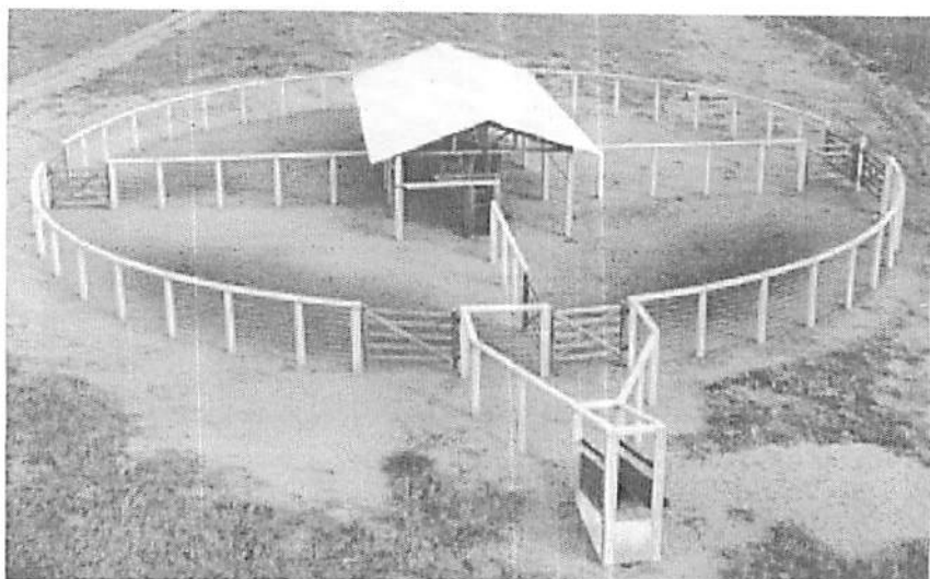
FIGURA 9.6 - Curral para manejo de bovinos com utilização de elementos pré-fabricados em concreto. Fonte: Cochos e Currais Itabira, 2004.
