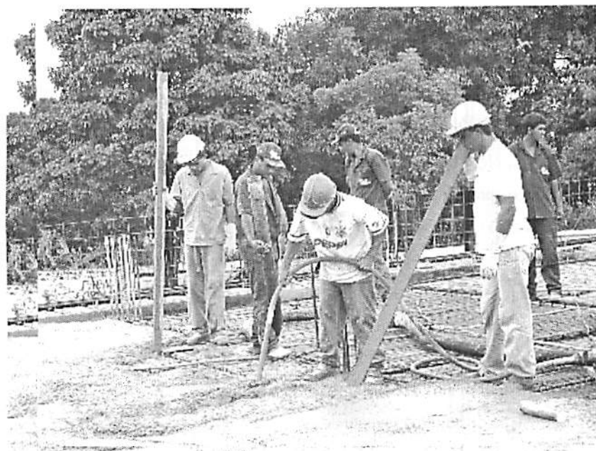
FIGURA 8.8 - Adensamento do concreto por meio de vibrador.
