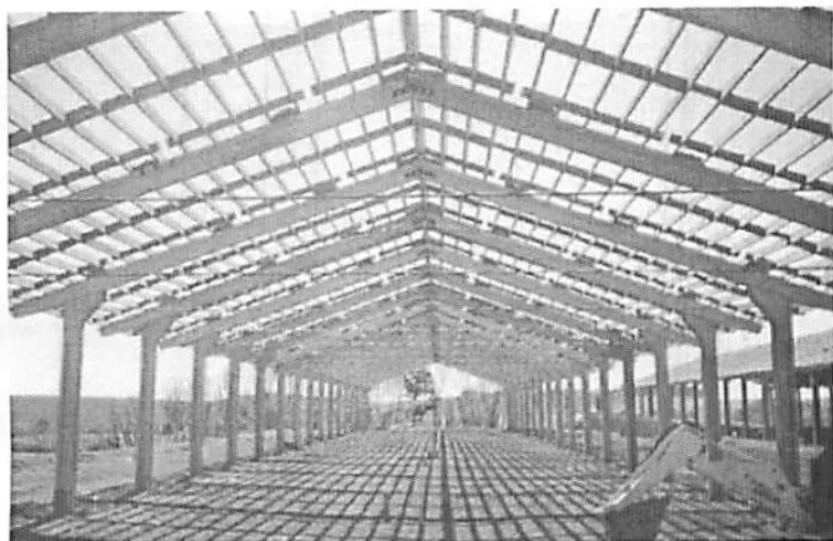
FIGURA 9.8 - Galpão com estrutura de pré-fabricados em concreto.
