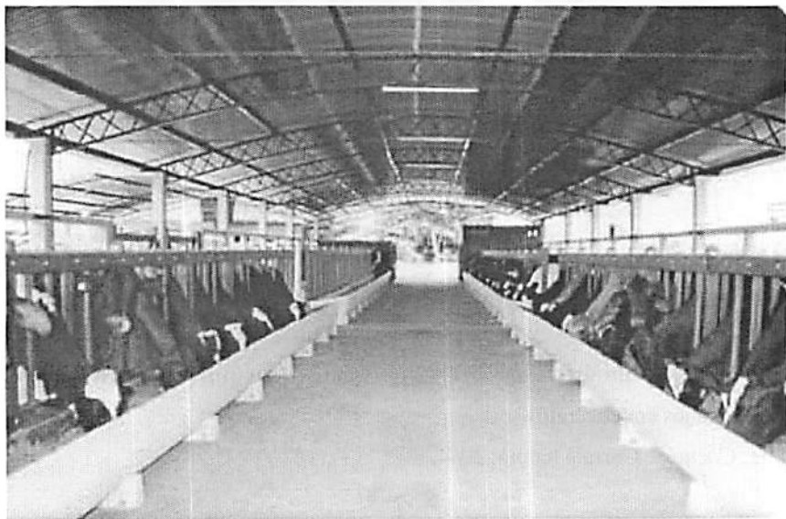
FIGURA 9.7 - Galpão para confinamento: piso, cochos e pilares em concreto. Fonte: Cochos e Currais Itabira, 2004.
