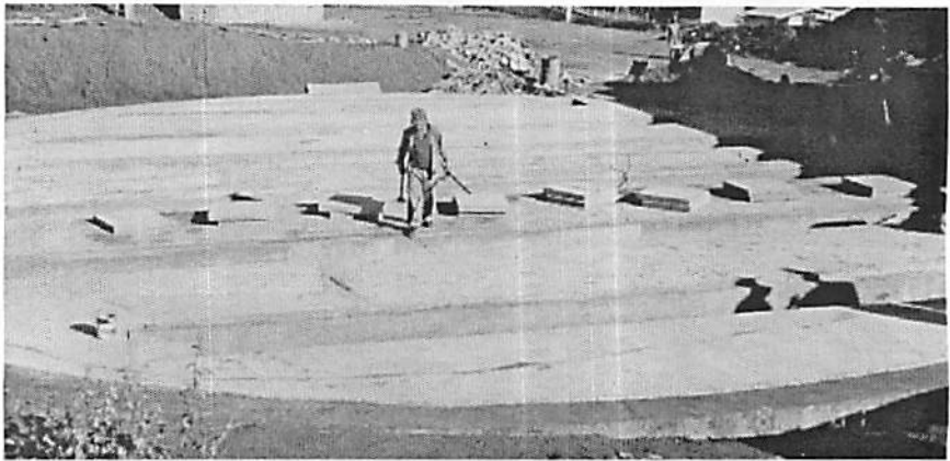
FIGURA 9.10 - Base em concreto para silo graneleiro. Fonte: Teixeira, V. H., 2003.
