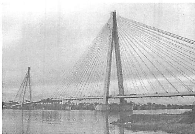
FIGURA 1.11 - Ponte sobre o Rio Paranaíba, divisa entre Minas Gerais e Mato Grosso do Sul.
