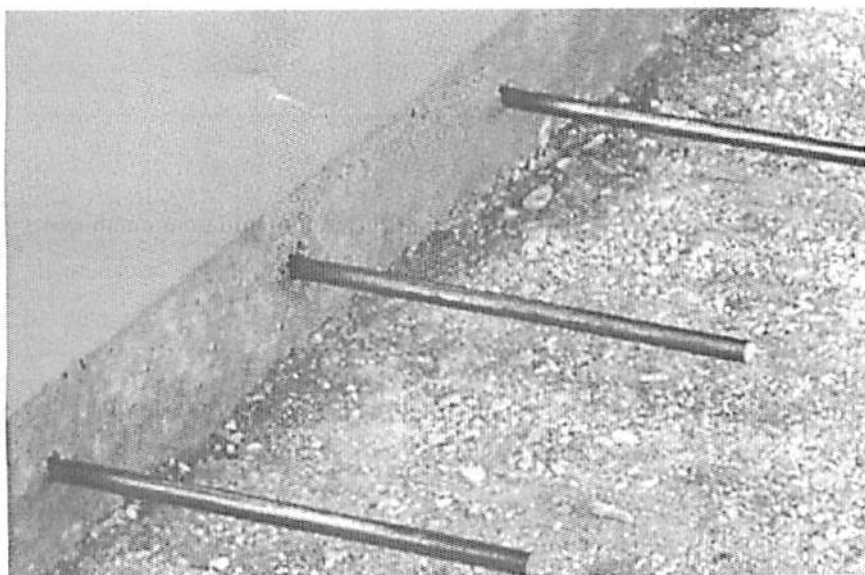
FIGURA 9.16 – Barras de transferência
