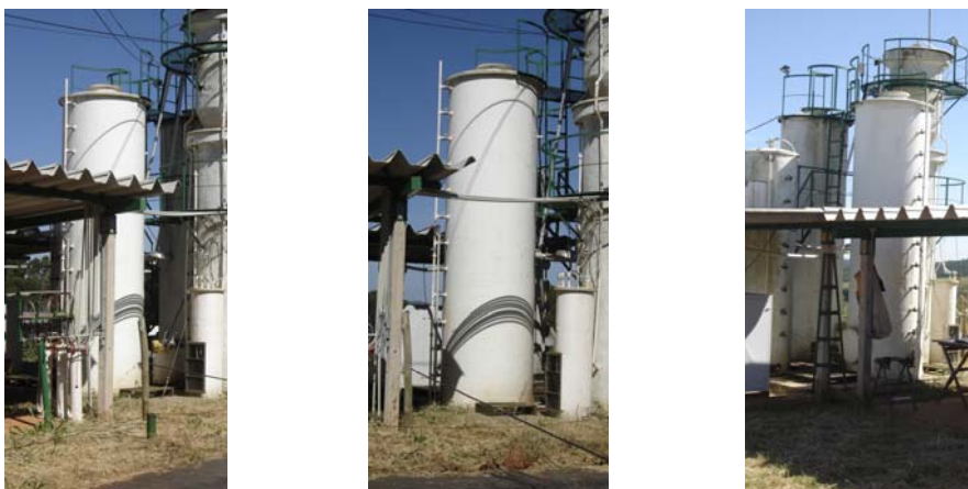
FIGURA 14. Sistema de lodos ativados (reatores batelada) usados no polimento do efluente proveniente do filtro anaeróbio híbrido, do sistema piloto de tratamento da água residuária do café localizado no NECAF/UFLA.
