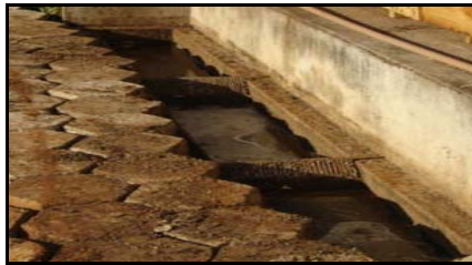
FIGURA 8. Tratamento preliminar, componente do sistema piloto de tratamento da água residuária do café localizado no NECAF/UFLA.
