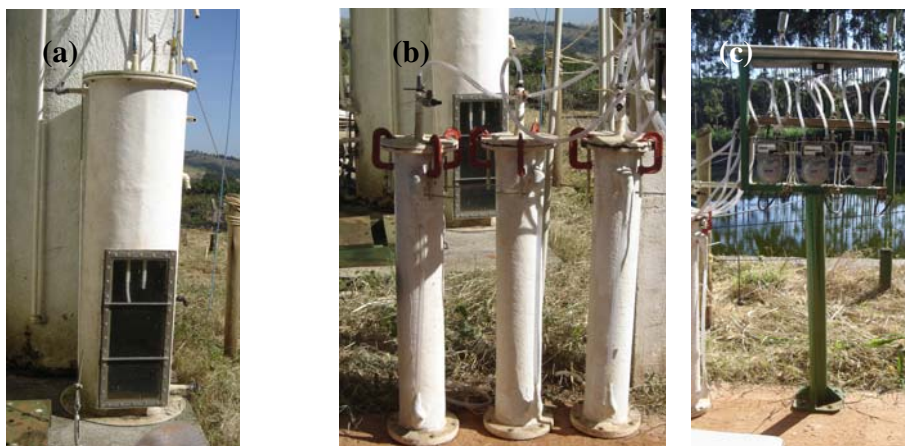
FIGURA 11. Vista parcial dos equipamentos do sistema piloto de tratamento da água residuária do café localizado no NECAF/UFLA. (a) Dispositivo de equalização de pressão do reator UASB utilizado na saída do biogás; (b) filtros de H 2 S; (c) medidores de biogás e lançadores de chama
