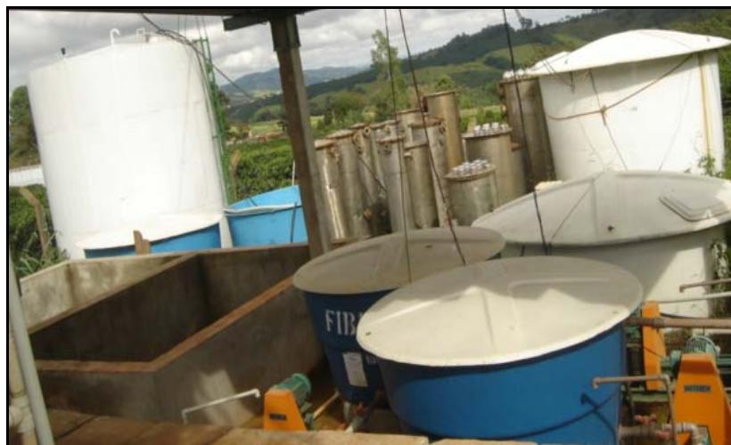
FIGURA 18. Reservatórios integrantes do sistema de tratamento do sistema piloto de tratamento da água residuária do café localizado no NECAF/UFLA.
