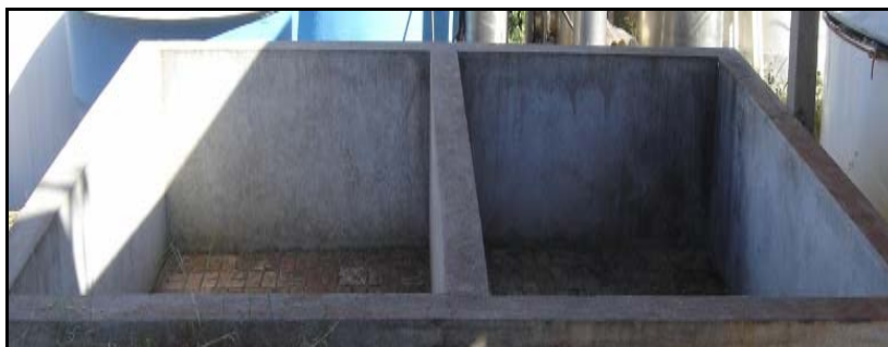
FIGURA 15. Leito de secagem para receber o lodo dos reatores do sistema piloto de tratamento da água residuária do café localizado no NECAF/UFLA.
