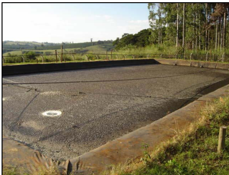
FIGURA 9. Lagoa de estabilização do sistema piloto de tratamento da água residuária do café localizado no NECAF/UFLA.
