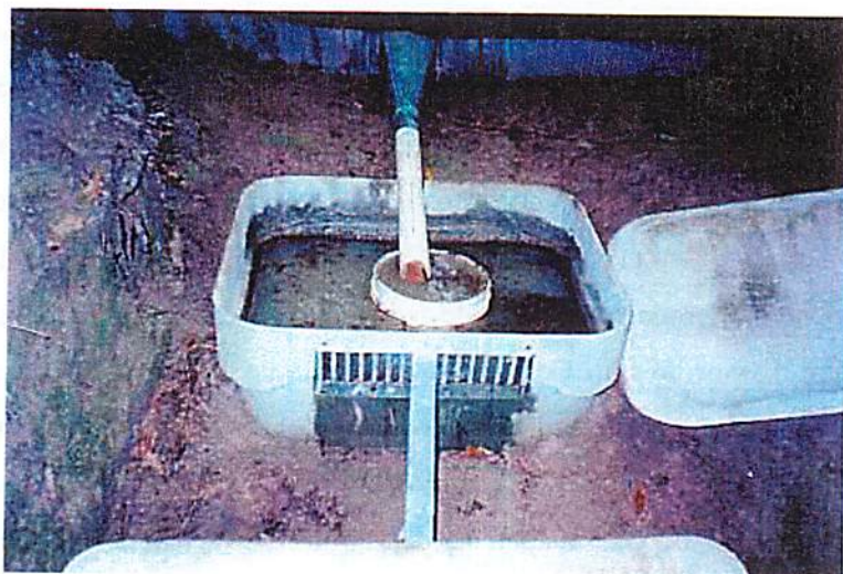
FIGURA 4 Tanque de sedimentação munido de um divisor do tipo Geib após uma chuva. Aracruz, ES, 2002.
