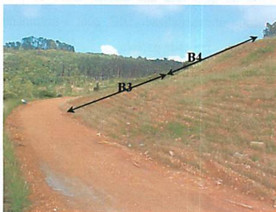
FIGURA 3 Detalhes do tapete verde implantado para minimizar a erosão após a remodelagem do terreno e a posição dos blocos 3 e 4 após o plantio da mudas.
