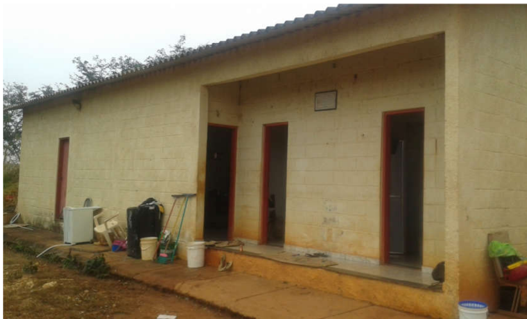
Figura 5 - Banheiros, escritório e refeitório da RECICLANEP.
