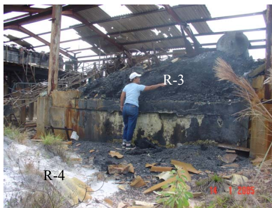
FIGURA 1 Pilhas dos rejeitos expostos na planta de tratamento da mina Delita.
