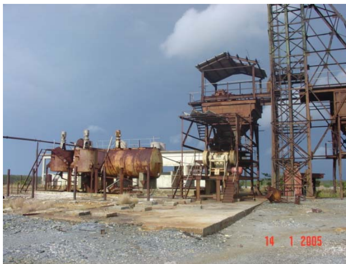
FIGURA 1B Vista parcial das antigas instalações da planta de tratamento inicial do minério de Delita
