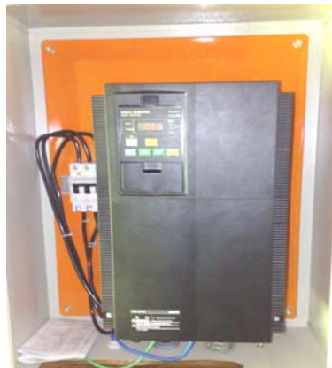
Figura 25 Foto do inversor de frequência instalado dentro do painel de proteção
