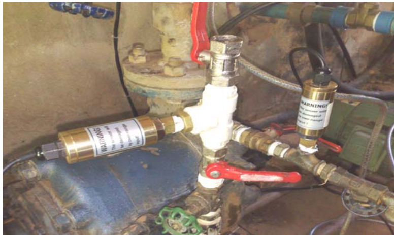
Figura 28 Transdutores de pressão instalados na unidade de bombeamento
