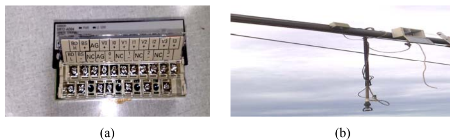
Figura 34 (a) Unidade remota da OMRON, modelo SRT2-AD04 e (b) instalação das unidade remotas ao longo da linha lateral móvel do pivô
