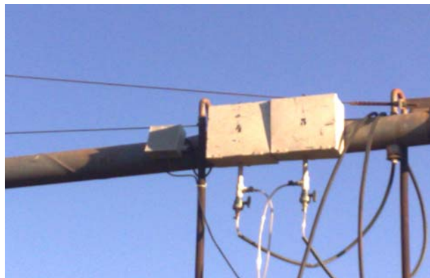
Figura 32 Instalação dos data loggers ao longo da linha lateral móvel do pivô central
