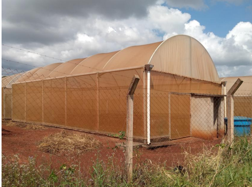
Figura 4 - Vista geral da casa de vegetação utilizada para a acomodação dos vasos cultivados com milho.
