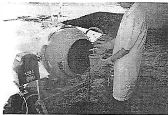
FIGURA 6 - Pulverização da água mais aditivo nas partículas dentro da betoneira
