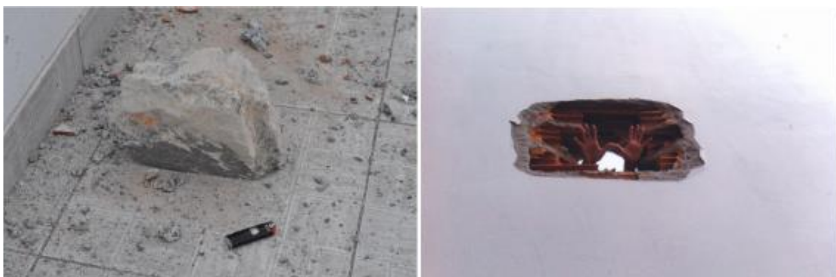
Figura 5 – Lançamento de rocha granítica em 03 de junho de 2014.
