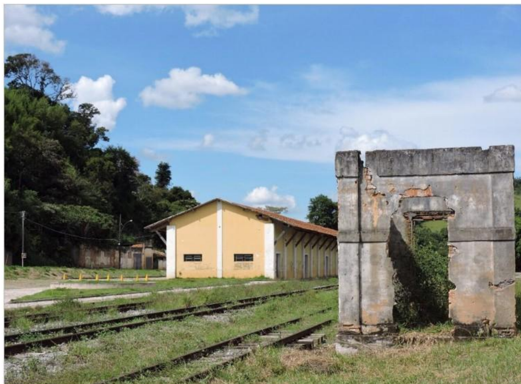
Figura 3.5 – Prédio do Galpão de Baldeação atualmente
