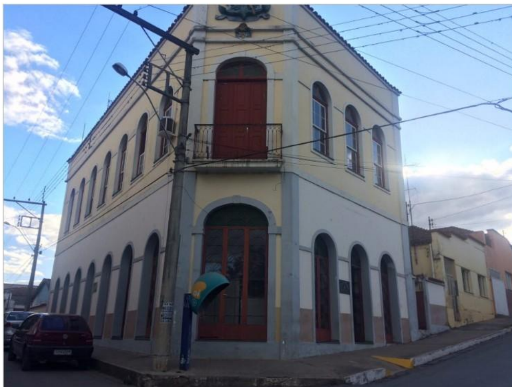
Figura 3.4 – Prédio Administrativo da RFFSA, onde atualmente funciona a Prefeitura Municipal
