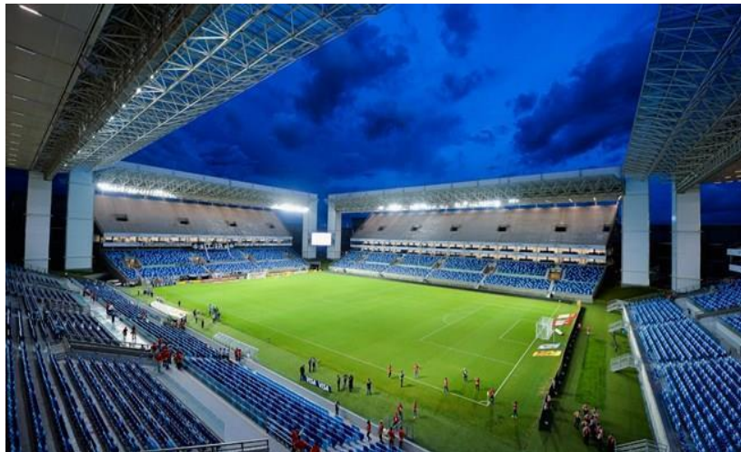
Figura 4.2 – Foto da situação atual da obra da Arena Pantanal
