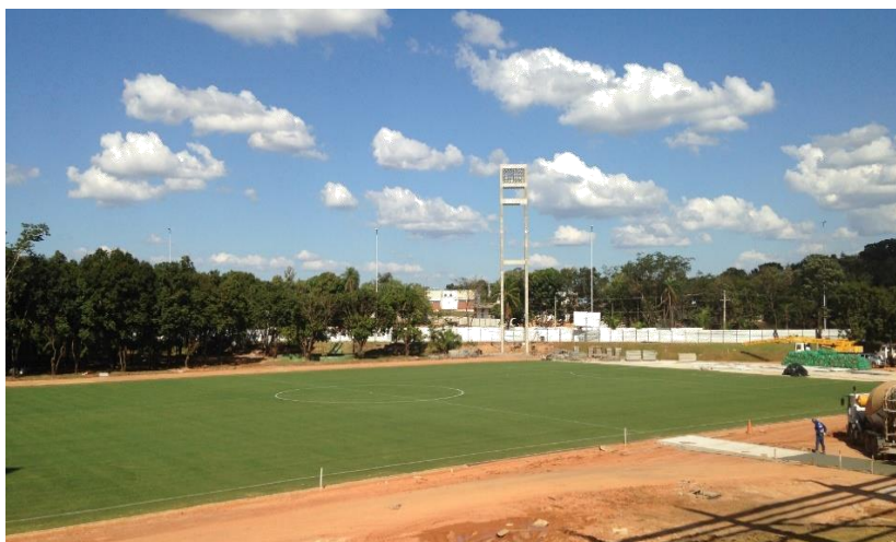
Figura 6.2 – Foto da situação atual da obra do COT da UFMT
