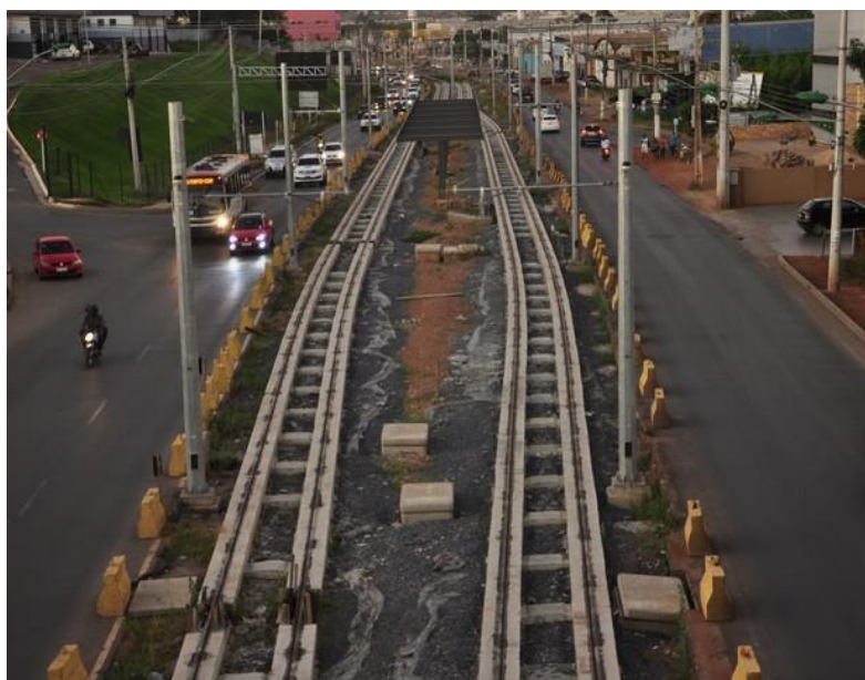
Figura 3.2 – Foto da situação atual da obra do VLT próximo ao aeroporto Marechal Rondon
