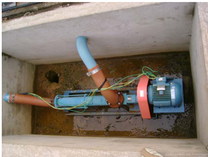
Figura 12 Equipamento motobomba usado para recirculação dos dejetos.
