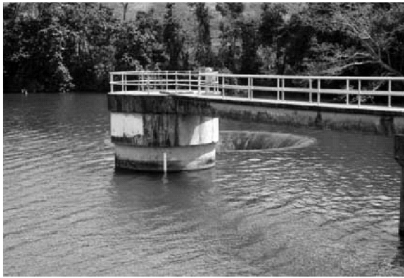
FIGURA 13-13 Vertedor tubular
