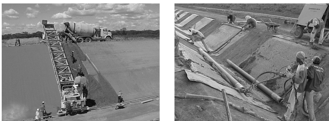
FIGURA 15.1 Revestimento utilizando mão de obra e maquinário
