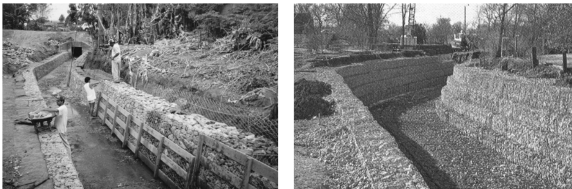
FIGURA 15.3 Canal revestido com gabião
