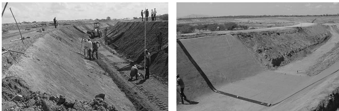
FIGURA 15.4 Revestimento de canal com manta sintética
