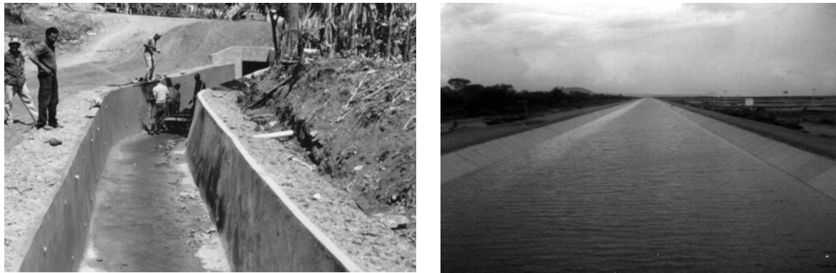
FIGURA 15.2 Canal revestido com concreto
