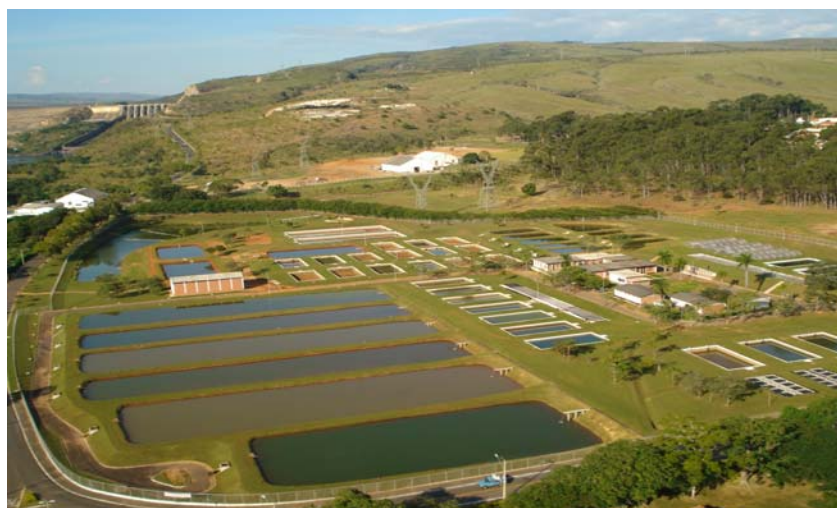
Figura 1 Estação de Hidrobiologia e Piscicultura da Eletrobrás/Furnas
