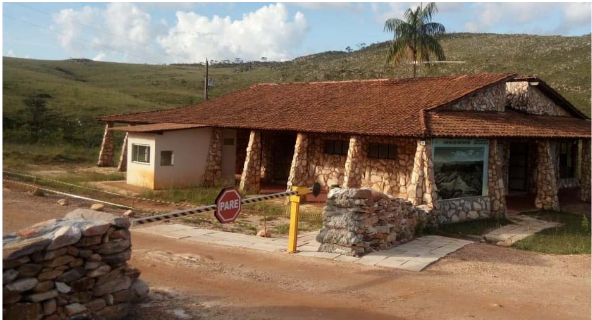
Figura 12 - Portaria 1 em São Roque de Minas.
