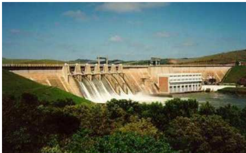
Figura 6: Barragem da UHE de Camargos (COMPANHIA ENERGÉTICA DE MINAS GERAIS - CEMIG, 2013)
