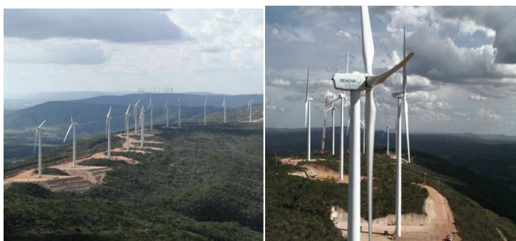
Figura 4 Vista aérea parcial do Complexo Eólico Alto Sertão I
