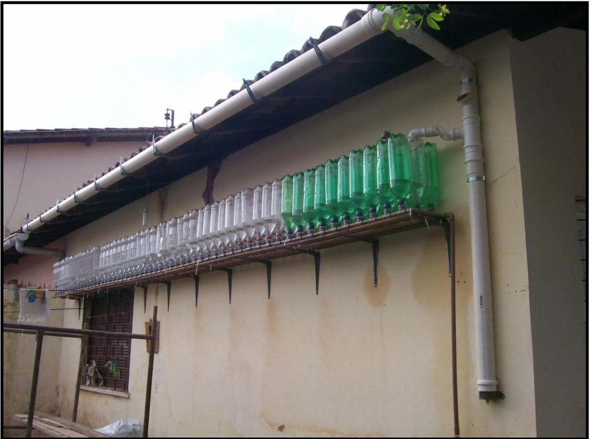
**Figura 37 – SAAC-SBE montado e instalado na URU**
