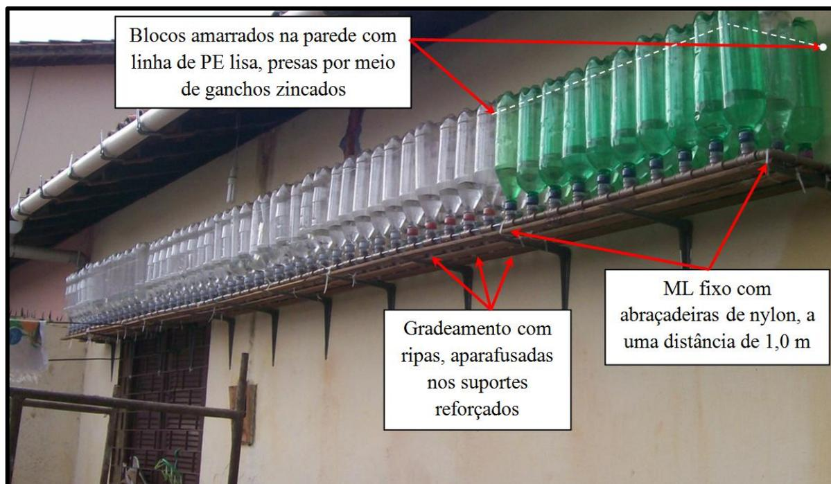
**Figura 35 – Blocos de garrafas de PET fixos na grade de ripa na URU**
