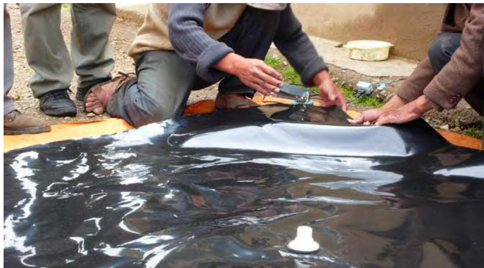
O reservatório é construído com 3 metros de polietileno tubular. Depois de colocar o flange no centro, fecham-se as laterais usando um selador manual de plástico.
