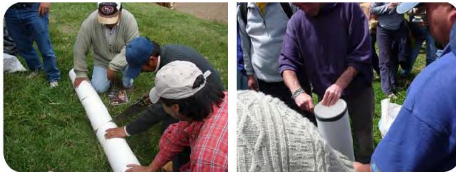
Os tubos de entrada e saída são de PVC de 6 polegadas de diâmetro. Deve-se proteger as bocas dos tubos de entrada e de saída, nas extremidades que vão ficar dentro do biodigestor, para que os tubos não danifiquem o plástico
