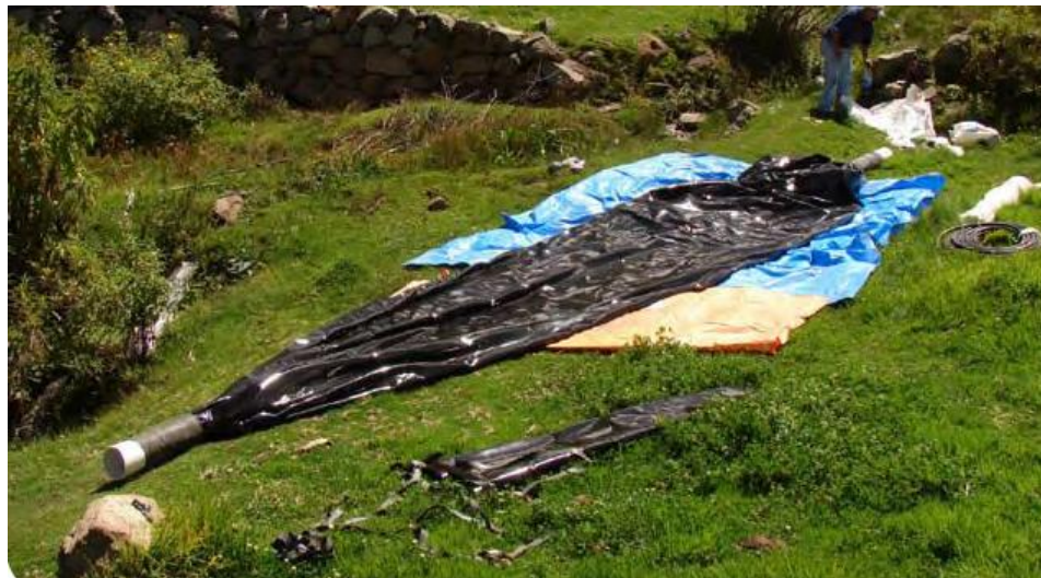
Biodigestor construído e pronto para ser instalado
