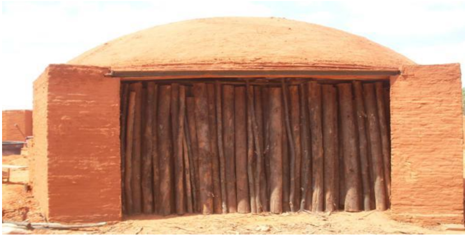
Figura 16 Enchimento vertical da camisa
