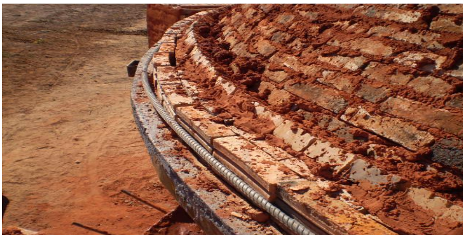
Figura 15 Colocação de cinta
