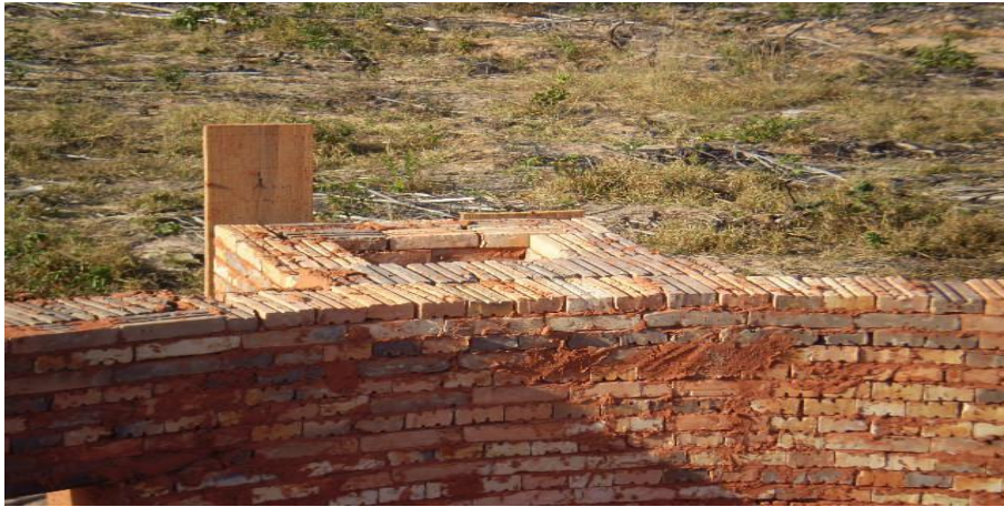
Figura 13 Construção da camisa cilíndrica
