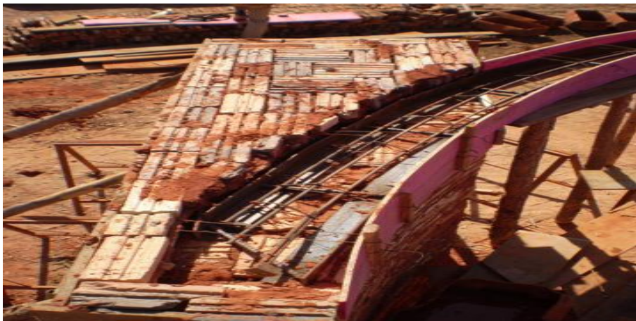
Figura 14 Colocação da soleira
