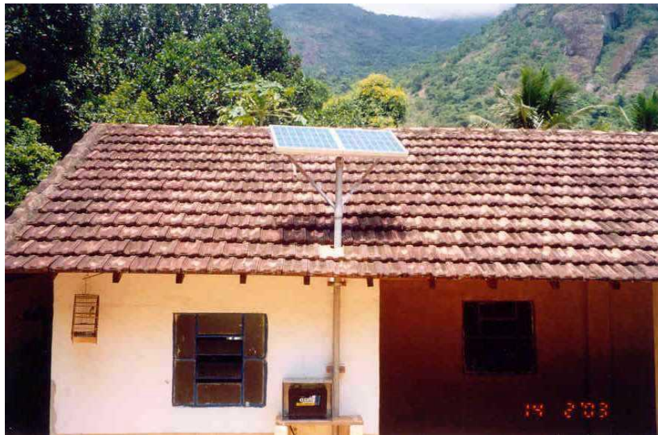
FIGURA 21 – PROPRIEDADE RURAL COM SISTEMA FOTOVOLTAICO FONTE: (SEINPE, 2006)
