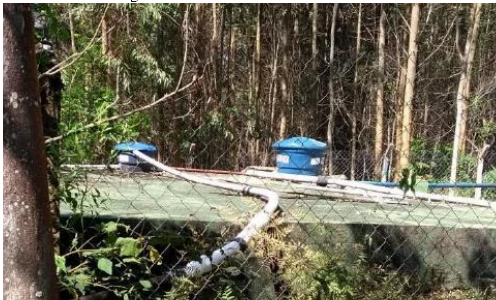
Figura 3 – Reservatório inicial da adutora.
