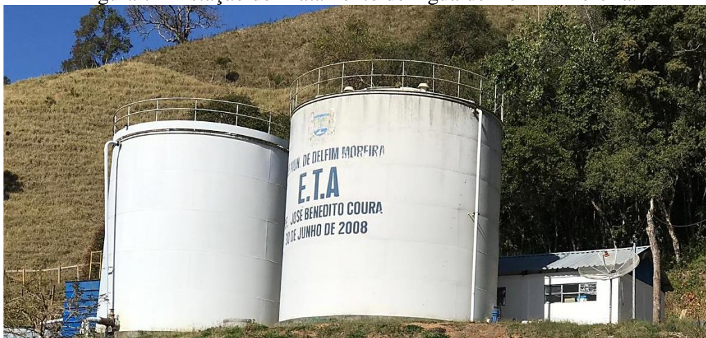
Figura 7 – Estação de Tratamento de Água de Delfim Moreira.
