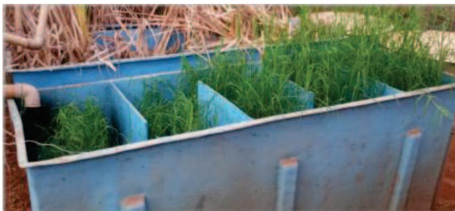
Figura 16 Crescimento gradativo da tifton-85 ao longo do sistema alagado construído (SAC) observado no final na terceira Fase de monitoramento após receber diferentes aportes de nutrientes provenientes dos efluentes da suinocultura
