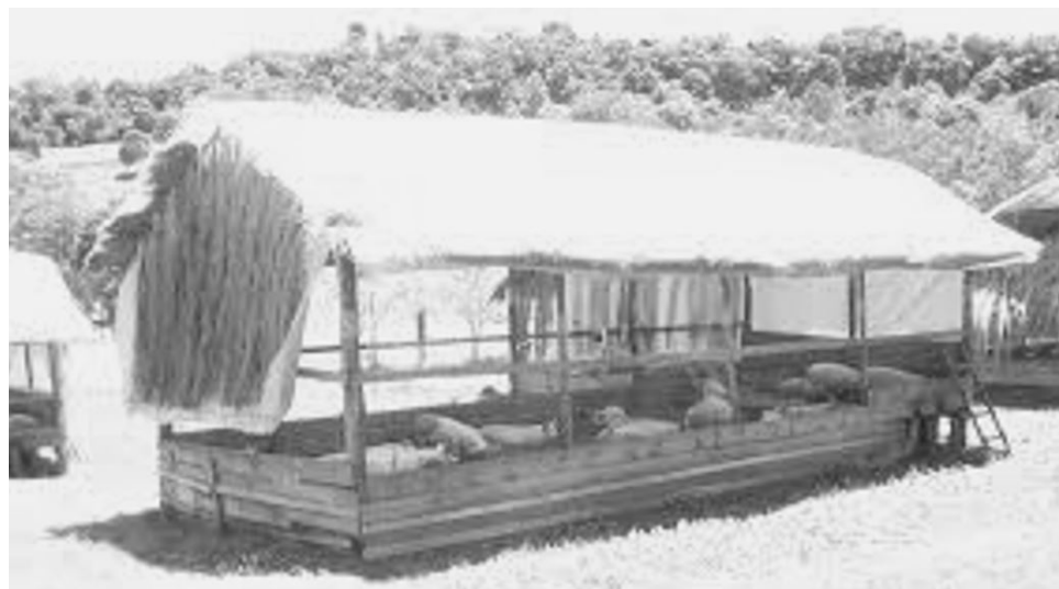
Figura 2: Telhado construído com palha. Fonte: Embrapa (2006).
