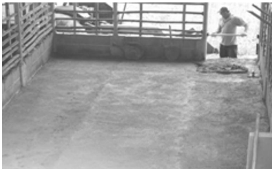
Figura 7: Piso de concreto, para que os suínos, no hábito de fuçar, não escavem buraco no chão. Fonte: Nepomuceno, MG, (2017).
