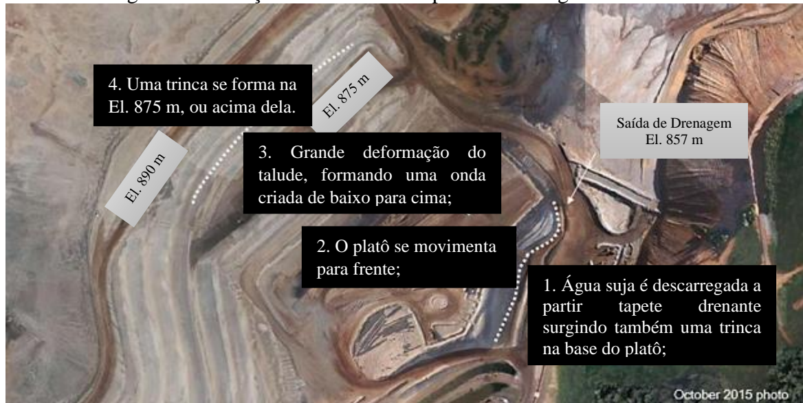
Figura 26 - Relação de eventos na ruptura da Barragem do Fundão.
