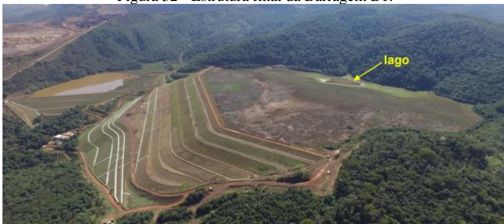
Figura 32 - Estrutura final da Barragem B1.
