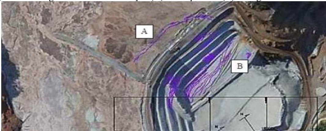
Figura 23 - Imagem das trincas de tração (A) e compressão (B) na região do eixo recuado.
