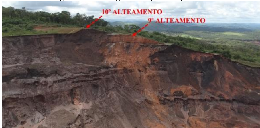
Figura 31 - Barragem B1 após rompimento.
