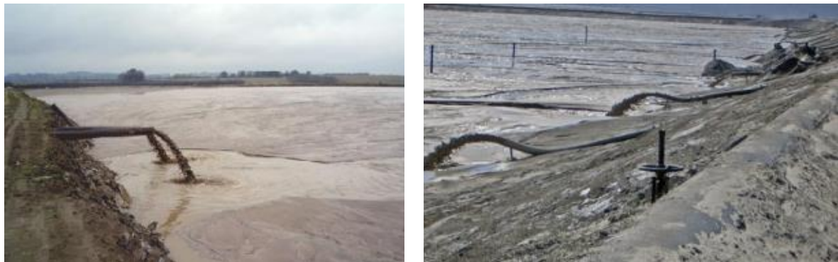
Figura 7 - Distribuição de spigots , em (a) em único ponto e em (b) múltiplos pontos.
