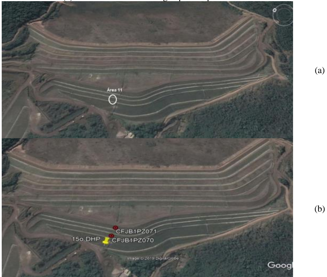
Figura 33 - Relação da área afetada, em (a) pela instalação do DHP 15, e em (b) aumento dos níveis de água para os piezômetros.
