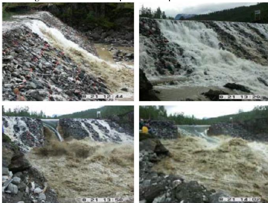
Figura 9 - Galgamento com erosão por fenda superficial em material não coeso.
