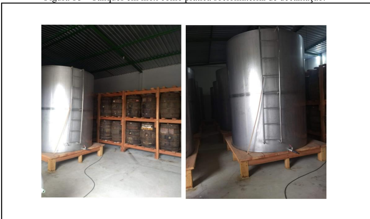
Figura 16 – Tanques em inox como prática sociomaterial de decantação.
